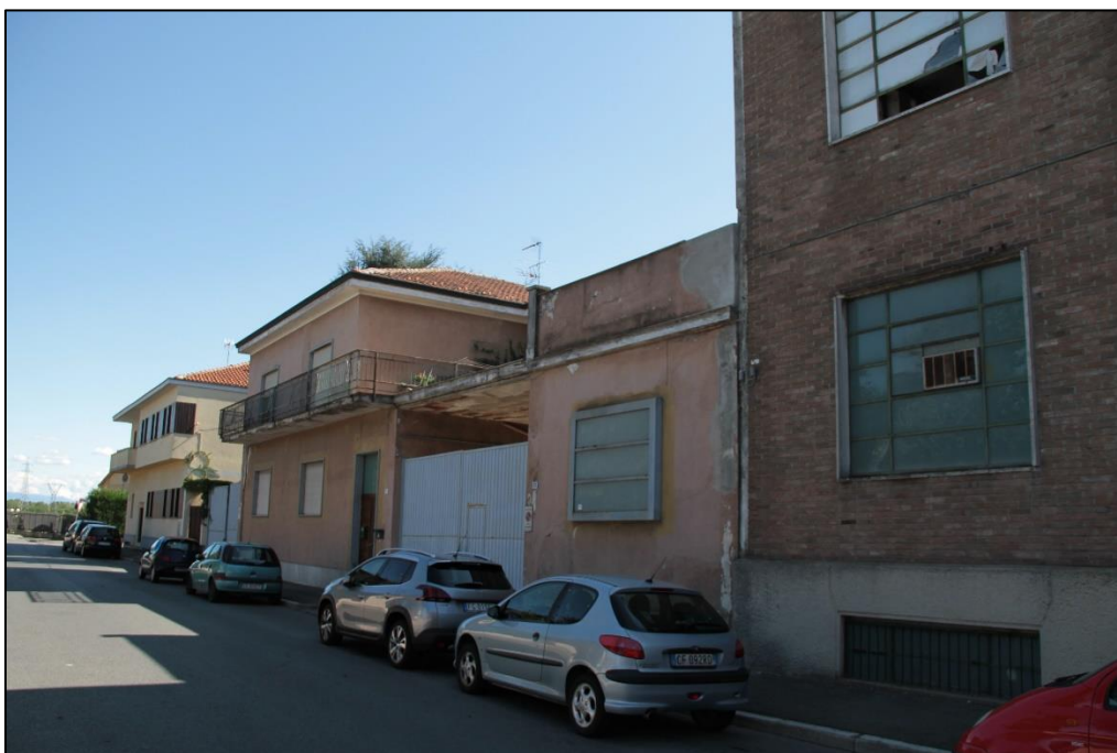
Figura 8: Edificio lato Via Piave
