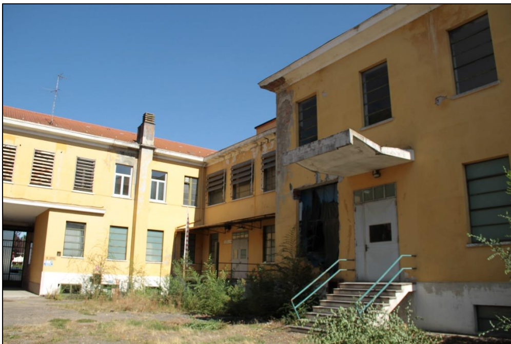
Figura 6: Area interessata dall'opera, vista interno cortile
