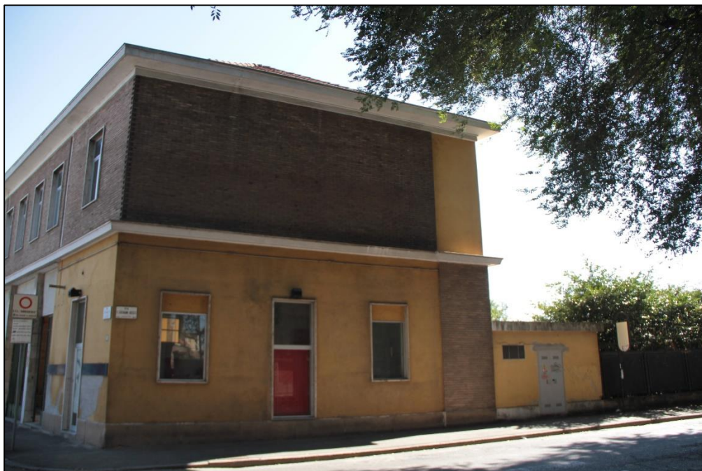
Figura 5: Area interessata dall'opera, vista angolo Via S. Giovanni Bosco – Via Piave
