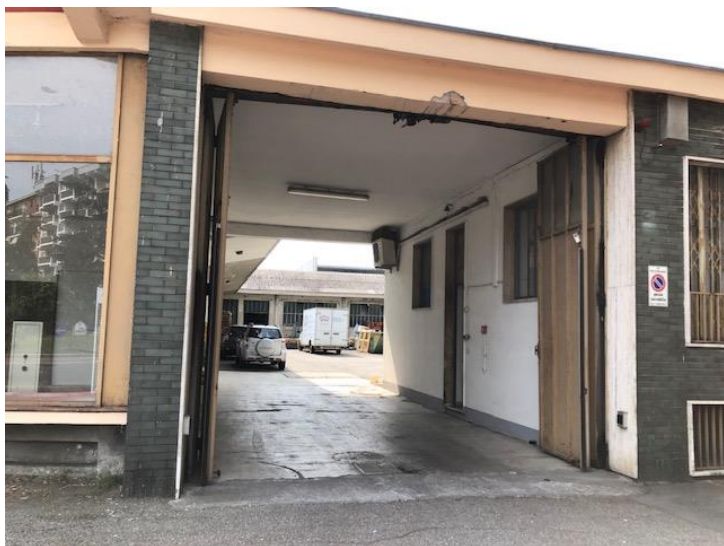
Ingresso stabile che verrà demolito
