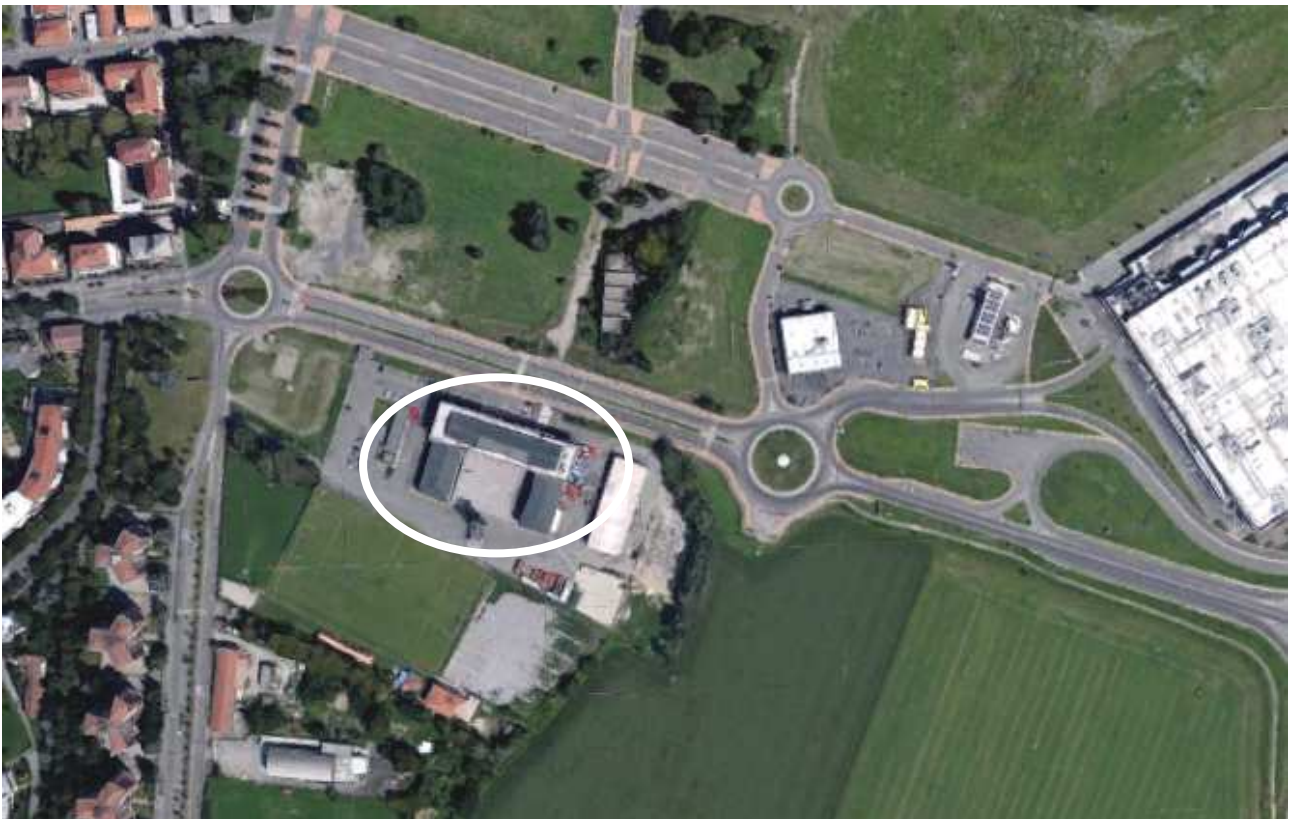
Figura 16: Sede Comando provinciale dei Vigili del Fuoco
