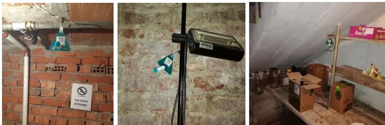
Figura 15 - Campionatori passivi alloggiati all'interno dei locali interrati di Spinetta Marengo
