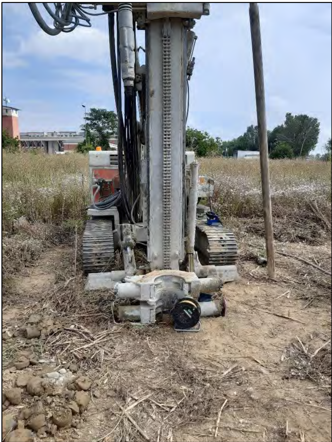
Prova permeabilità L04
