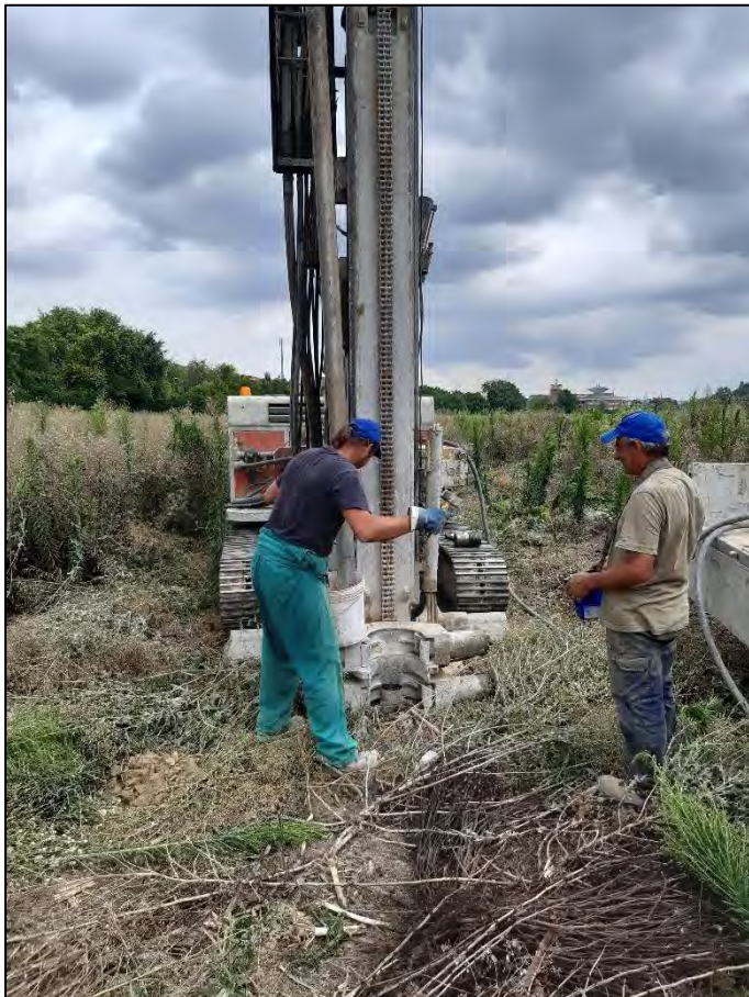
Prova permeabilità L05
