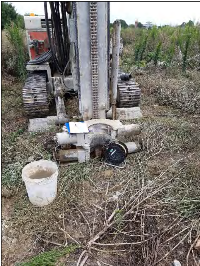
Prova permeabilità L03
