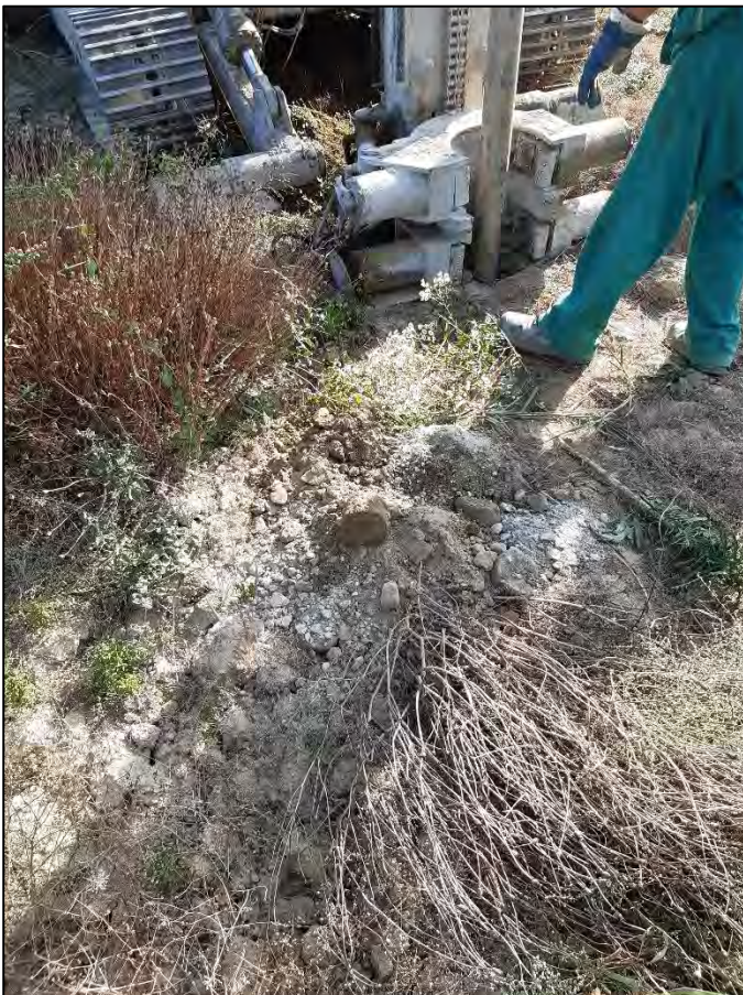
Prova permeabilità L01
