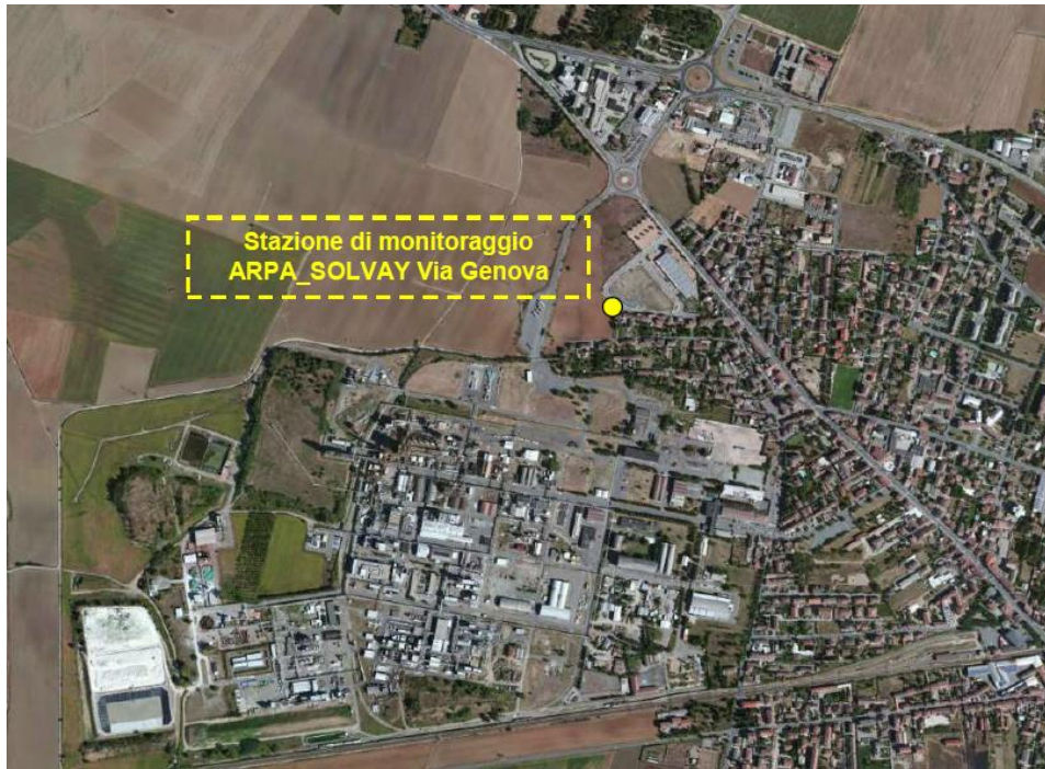
Immagine n° 2: ubicazione della stazione
