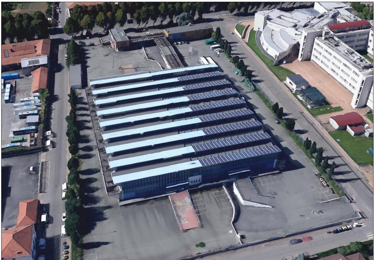
Vista direzione da Via Vinzaglio (ante lavori)
