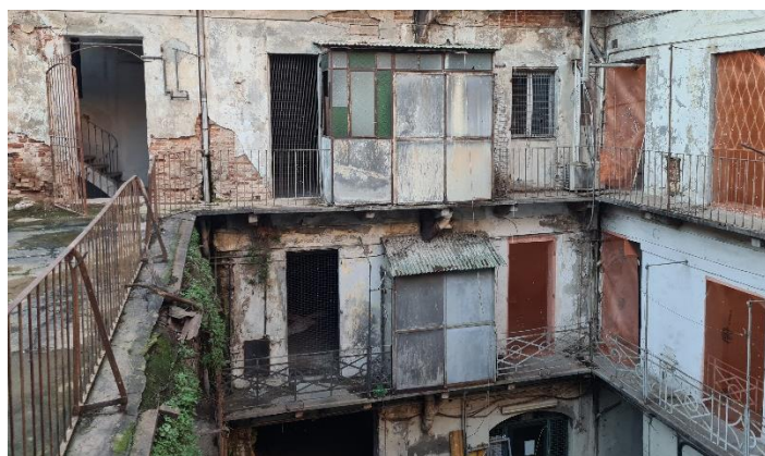
Veduta del fabbricato principale sul lato cortile
