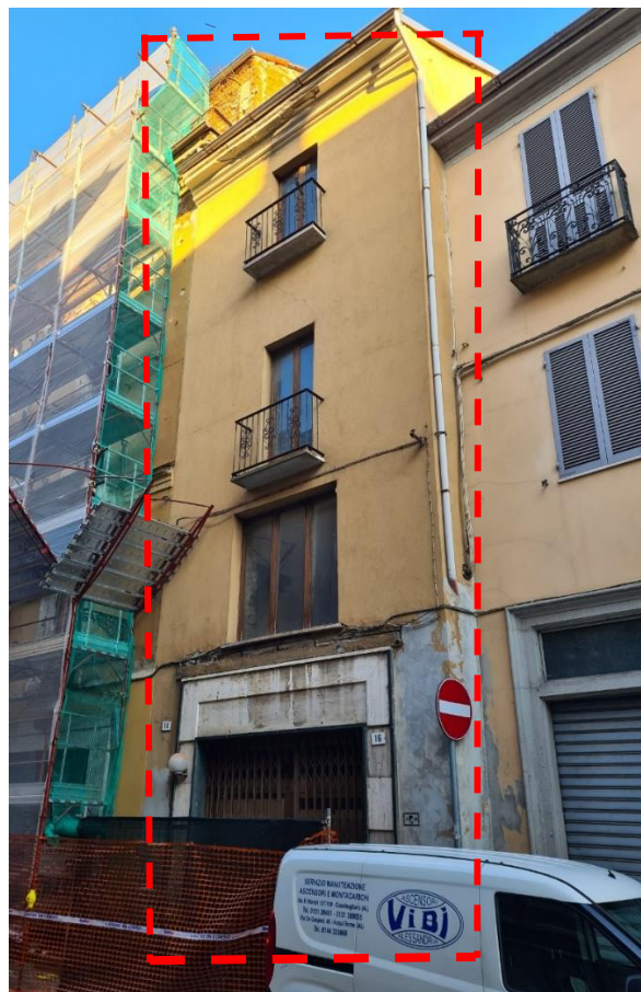
Veduta dell'edificio "secondario" del tutto privo di elementi decorativi
