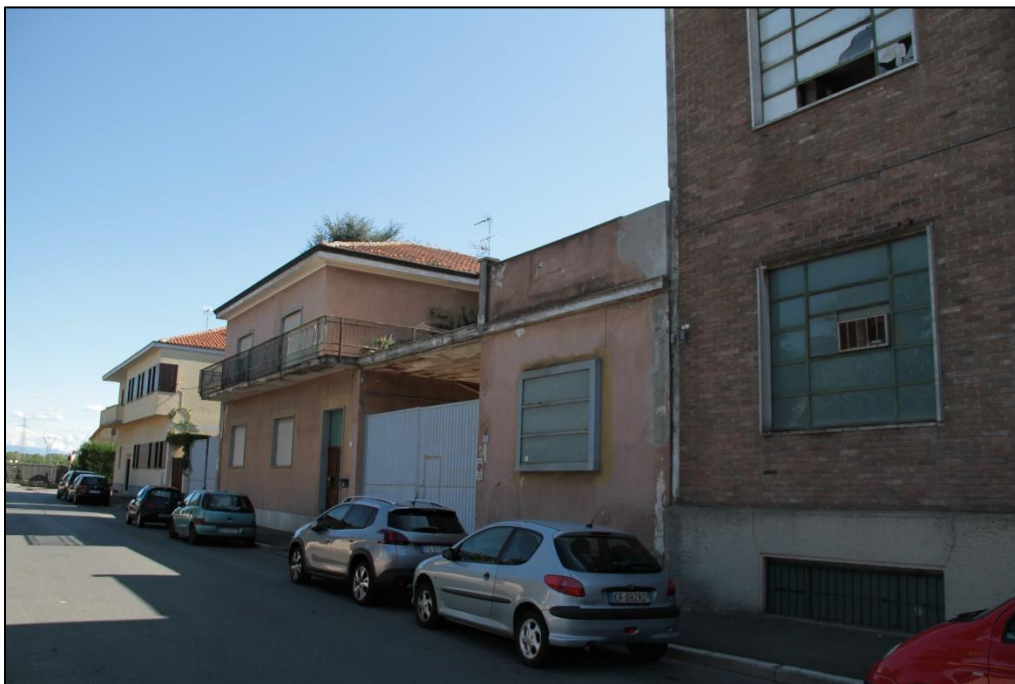
Figura 8: Edificio lato Via Piave
