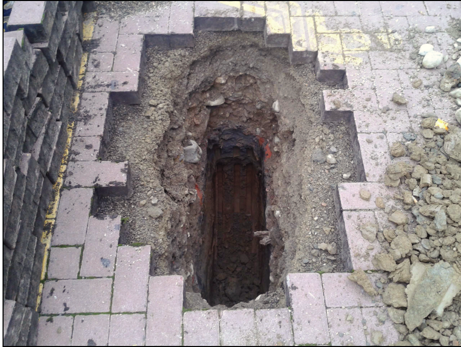
foto 2: particolare trincea T1
