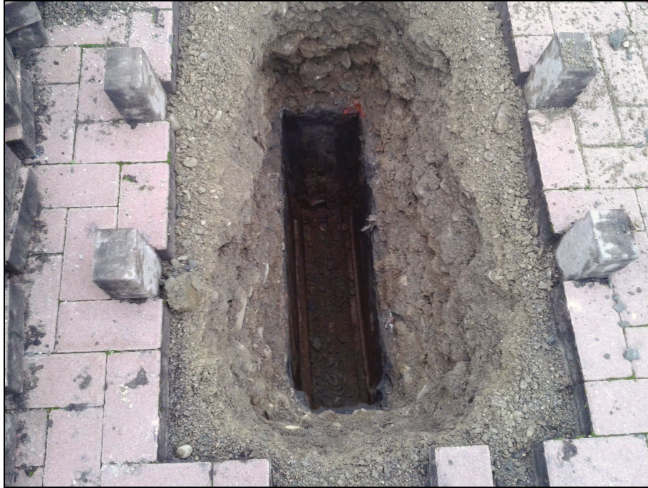
foto 4: particolare trincea T2
