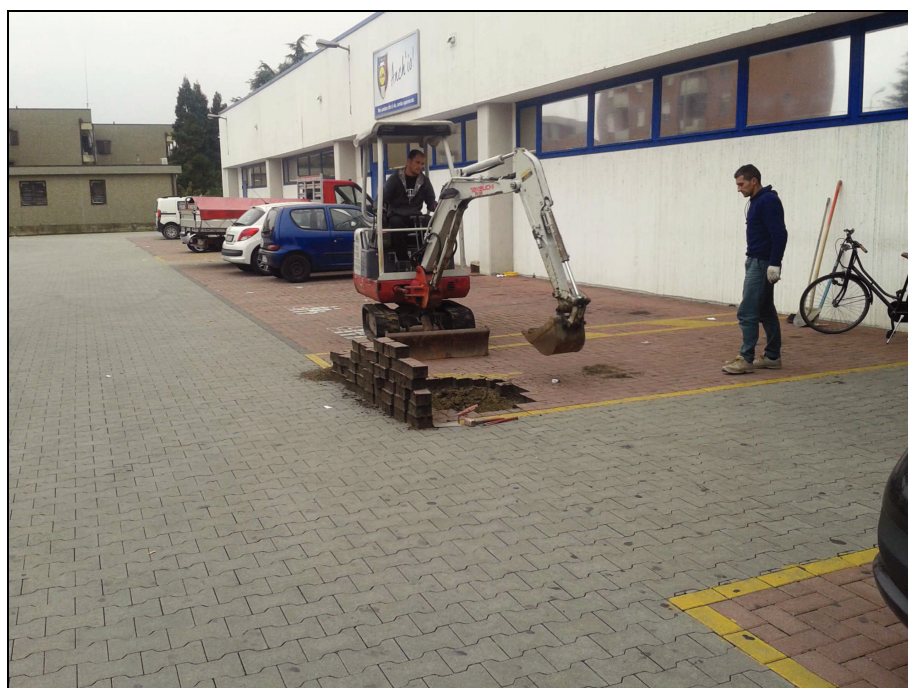
foto: 1 ubicazione trincea T1
