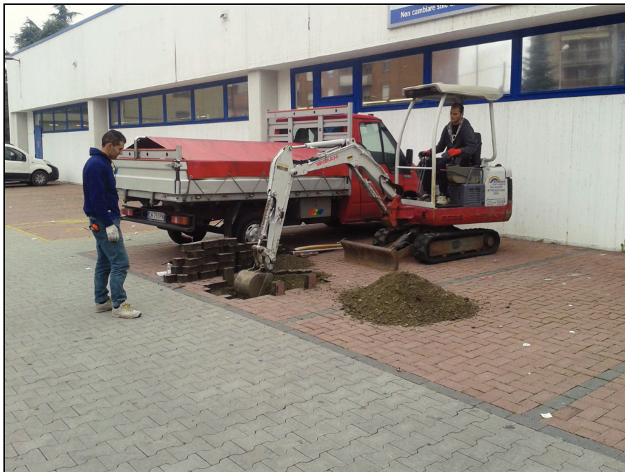
foto 3: ubicazione sondaggio T2
