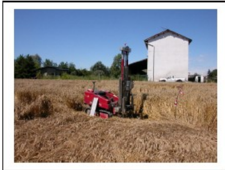
Foto 1: Posizionamento prova penetrometrica dinamica P7.
