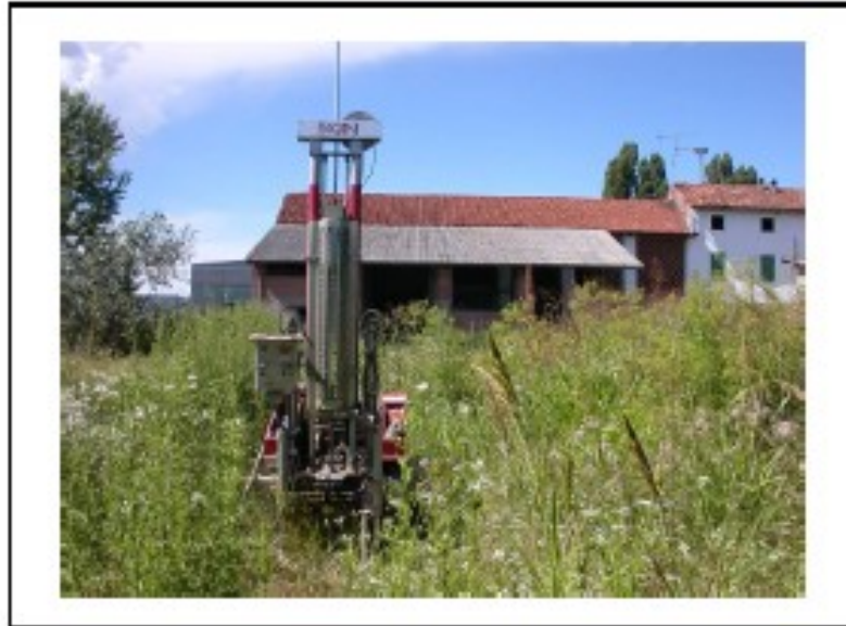
Foto 3: Posizionamento prova penetrometrica dinamica P9.
