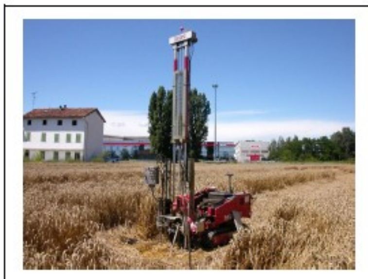
Foto 2: Posizionamento prova penetrometrica dinamica P8.
