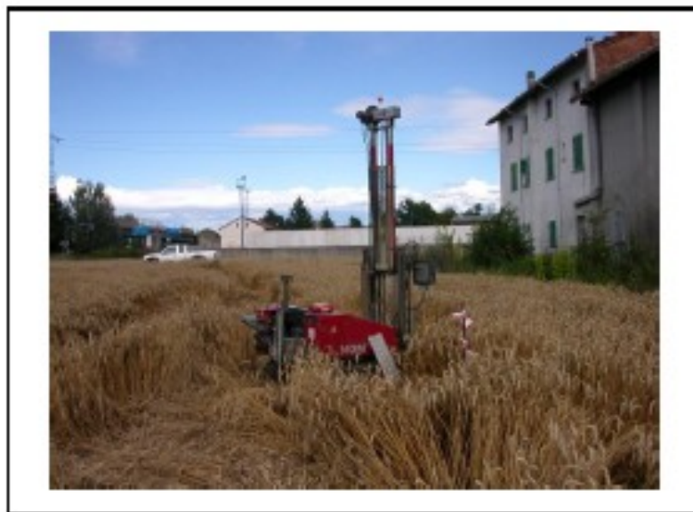
Foto 4: Posizionamento prova penetrometrica dinamica P10.
