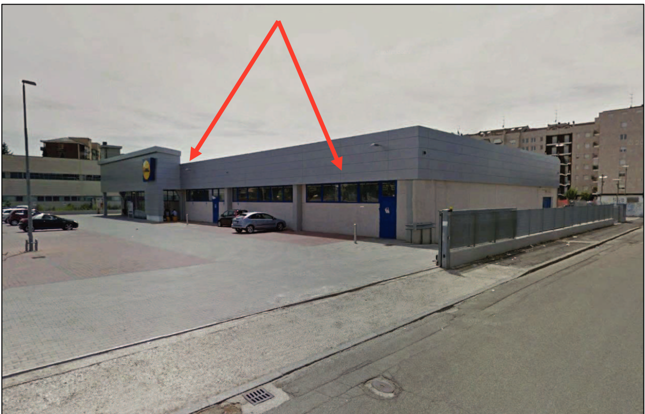
Foto 1 – Vista del lato est del punto vendita, con indicazione del lato in cui si prevede l'ampliamento in progetto.
