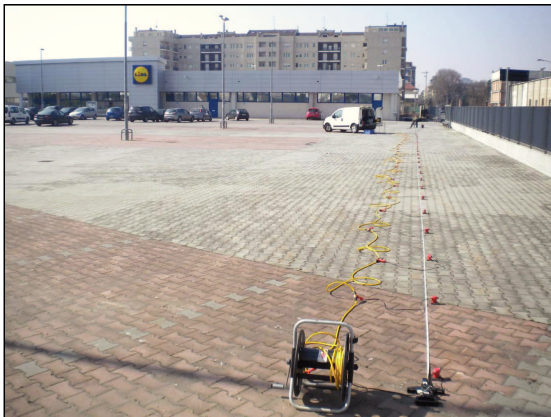
Figura 3: Vista dello stendimento MASW effettuato.
