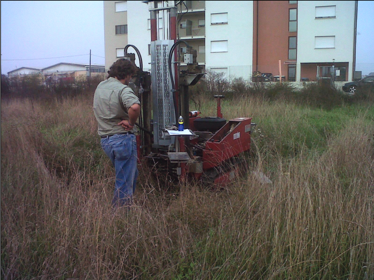
Penetrometro pagani TG 63-100 KN - area comparto 1 Via Scazzola, EDIFICI DI CIVILE ABITAZIONE IN PROGETTO - Data: 10-11 ottobre 2012.
