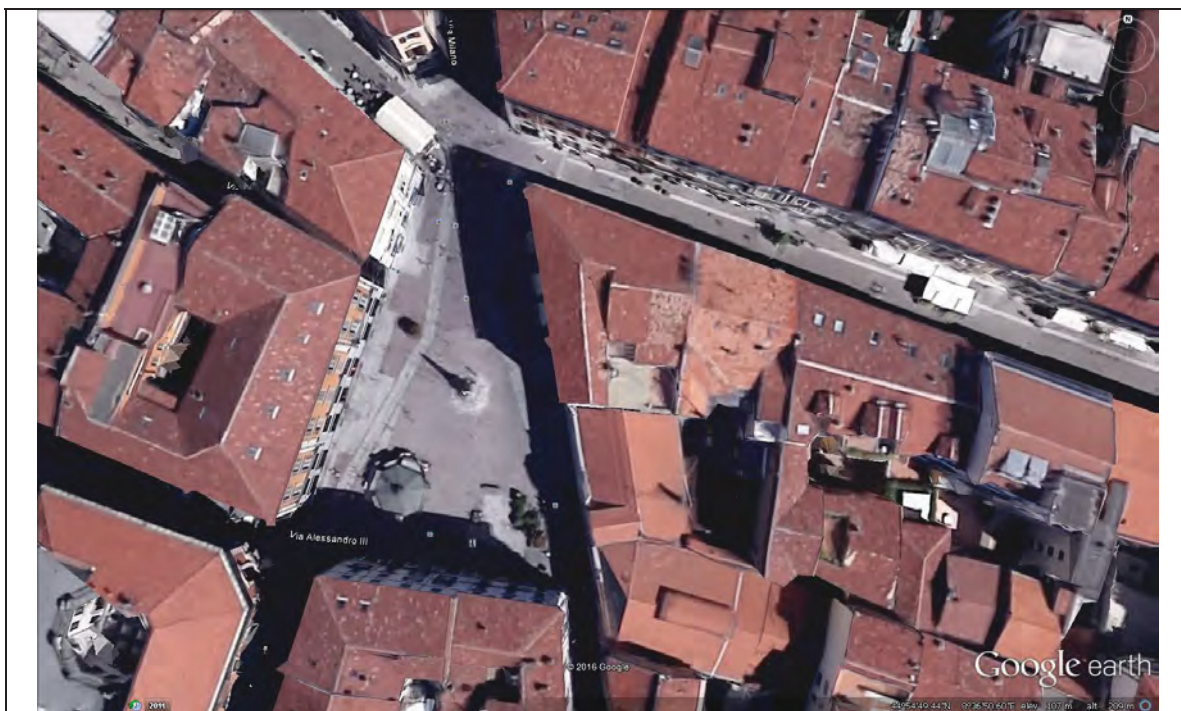
Immagine aerea dell'area di studio nella quale è inserito il Cinema Moderno
