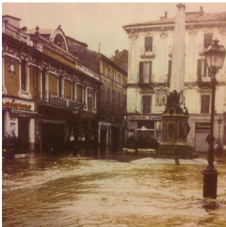
Fotografia del 6 novembre 1994: il fabbricato fu direttamente interessato dagli eventi alluvionali.
