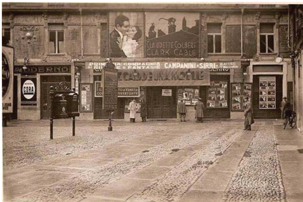
Fotografia del 1934: la facciata risulta ancora integra. Esiste ancora la pensilina in ferro e vetro, le aperture sull'atrio d'ingresso sono ancora divise.
