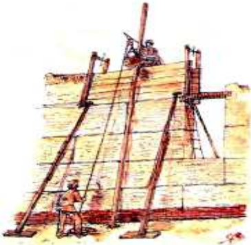
Realizzazione in sito.
